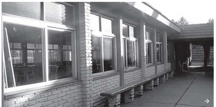
lo que incluyó el reemplazo total de las carpinterías, de la instalación eléctrica y de los artefactos de iluminación; ejecución de piso de hormigón; reemplazo del revestimiento de madera por revestimiento acrílico texturado; el tomado de juntas de la mampostería y la pintura completa de techo y de paramentos exteriores.
